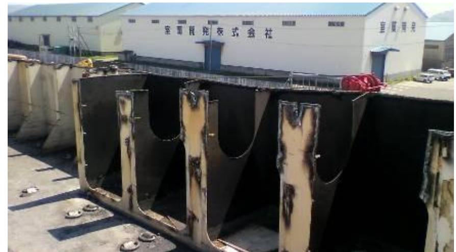
A cutting method that leave the outer frame to prevent falling down of workers 転落防止のため、手すり部分を残して切断する
