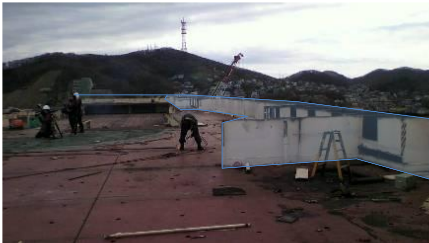
A cutting method that leave the outer frame to prevent falling down of workers 転落防止のため、手すり部分を残して切断する
