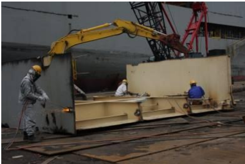
③ Cut to the possible size to load truck トラックサイズに切断
