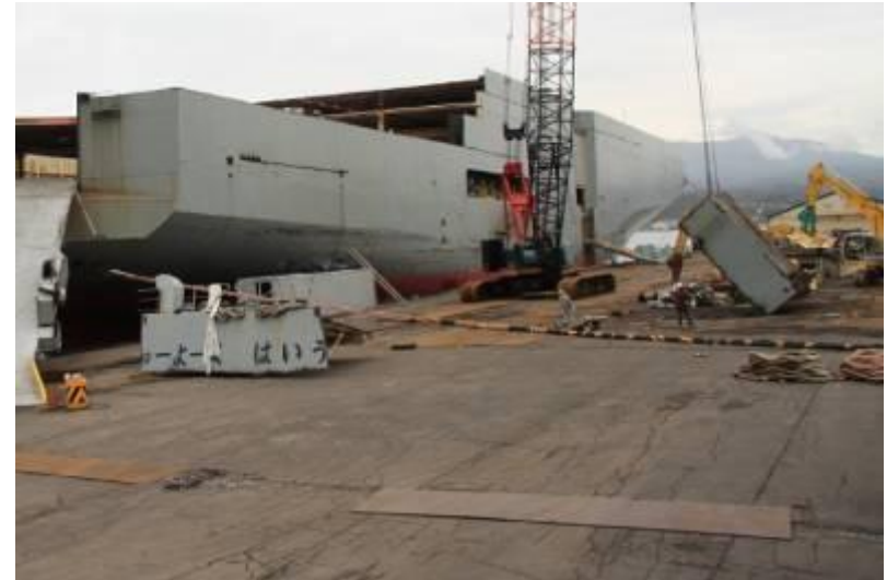
② Turn over the block 船体ブロックの転回
