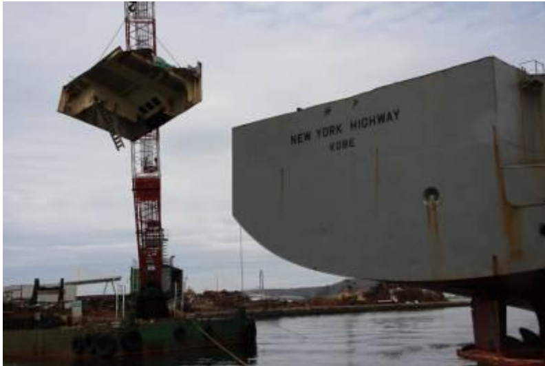
① Pull up and down the 20tons block by crane 約20tonの船体ブロックの吊り降ろし作業
