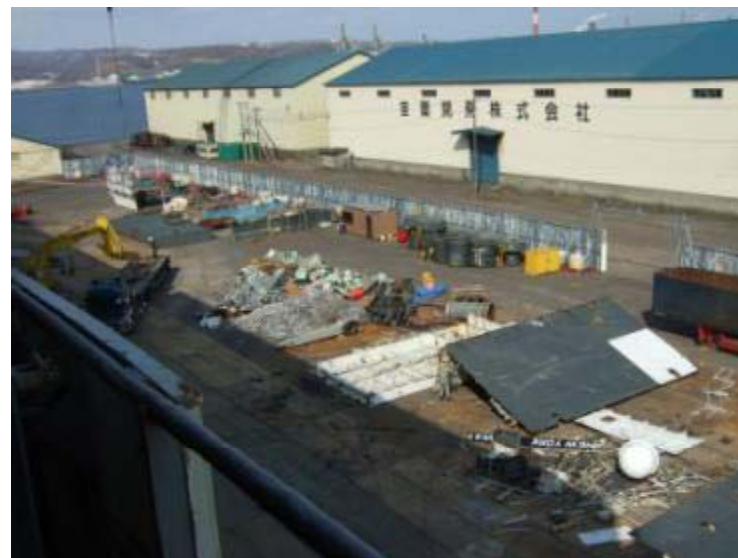
図 解体船舶から見下ろしたヤード
