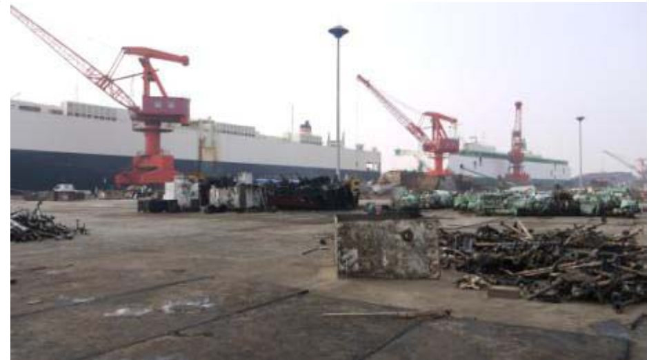
PCC船2隻が接岸し、解体中
