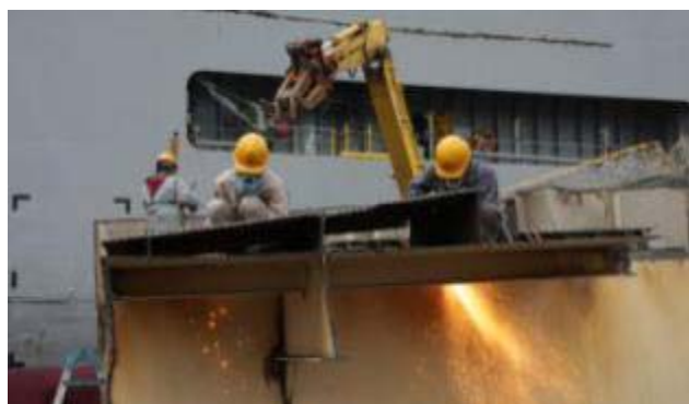
手作業による切断作業の省略
